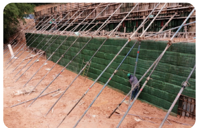
5 Muros en tierra con reforzamiento con geosintéticos
