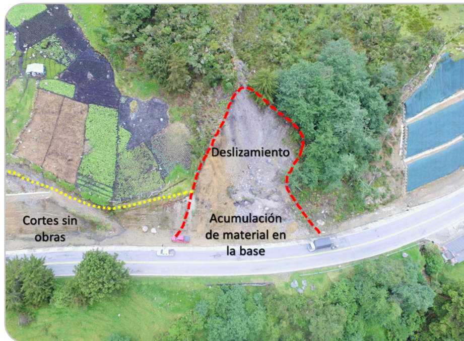
Costado derecho PK 91+215 vía Pamplona – B/ga ←
