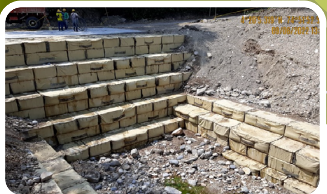
2 Bloques de geosintéticos rellenos de suelo
