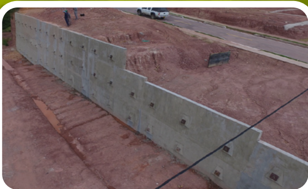
1 Muros en concreto armado
